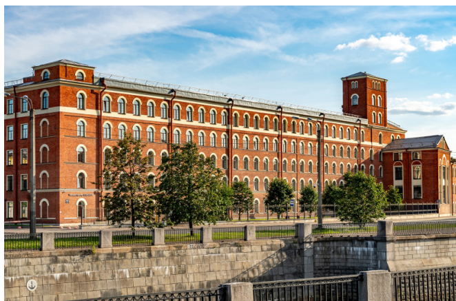
Наб. Обводного канала, д. 60
